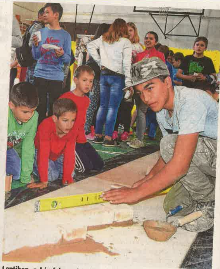
Lentiben, a Lámfalussy-iskolában közelről figyelhették a kisiskolások a falazás és a szintezés technikáját
