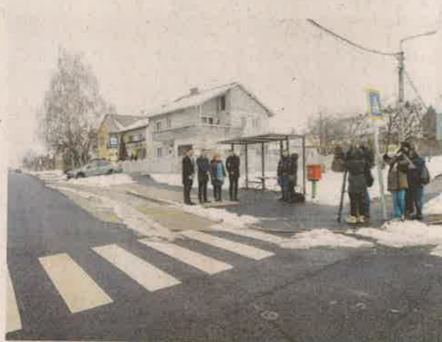
A közművek cseréjét követően a szakasz burkolatát csaknem 300 méter hosszan helyreállították
