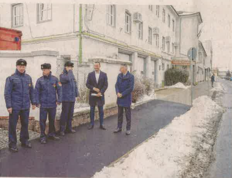
A munkások újult meg a tűzoltóság előtt, a csapadékvíz-elvezetést is megoldották
